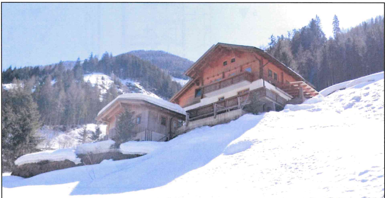
Foto: Bestehende Gebäude auf der Gp. 109/2 KG Hopfgarten in Deferegggen
