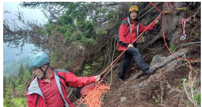
Aufbau der Seilbahn
